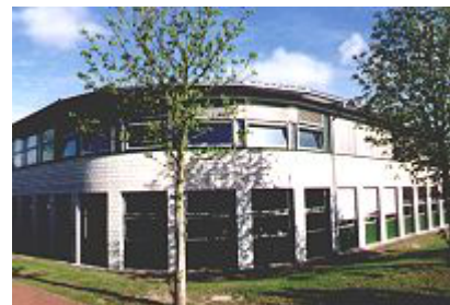
Der weitere Bau an der Gesamtschule in Brinkum war ein großer Schritt zum Abschluß des Schulkonzeptes in der Gemeinde Stuhr.
